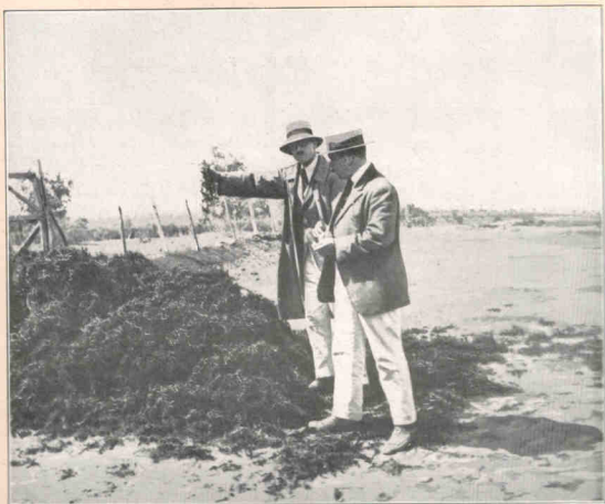
COMMENCEMENT DE L'ÉCRAPPAGE
